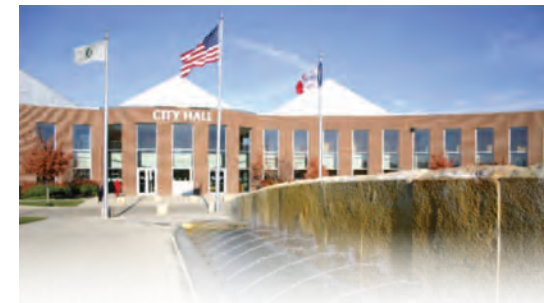
WEST DES MOINES CITY HALL
